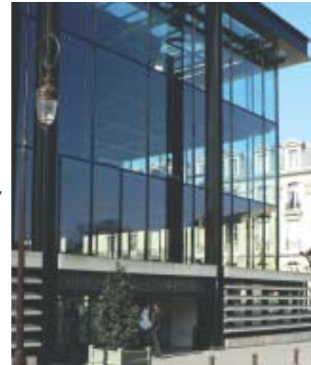
La structure porteuse en acier permet une transparence de l'enveloppe. Médiathèque à Reims (51), Jean-Paul Viguier.
